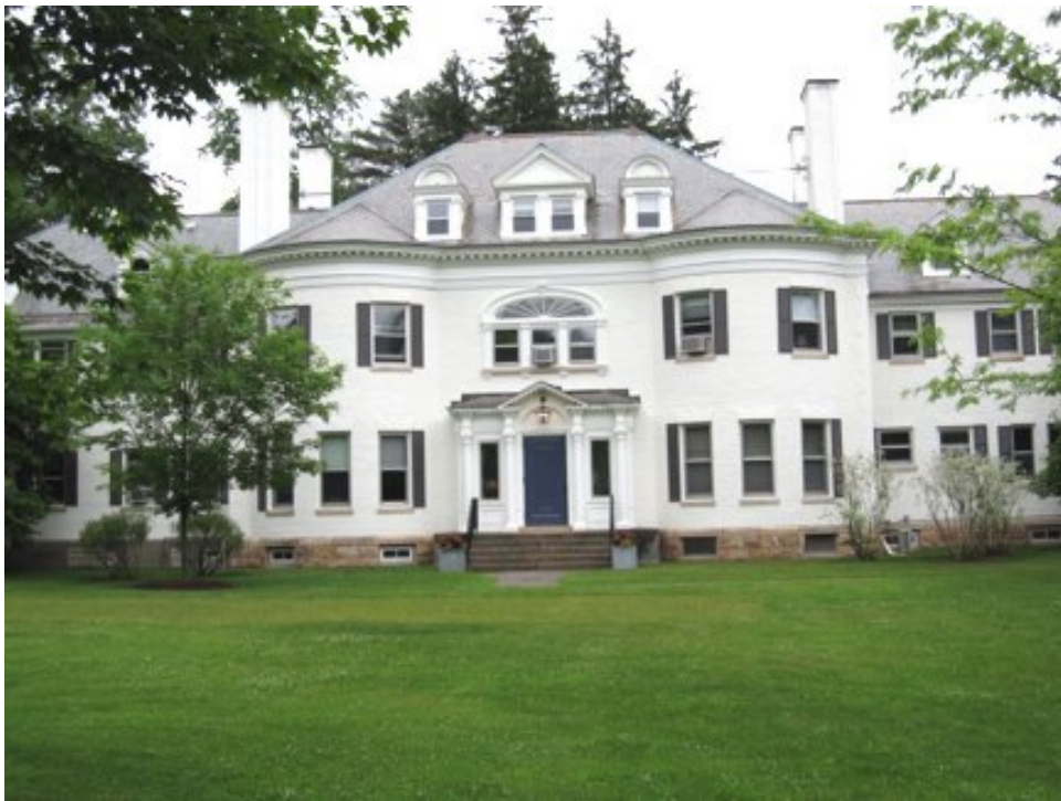
Austen Riggs Center
